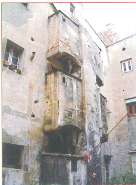
Vista parcial del registre vertical de lavabos de la façana de l'edifici nord-est de la finca. Podem distingir el calaix central i les estances suportades amb volta i permòdol
