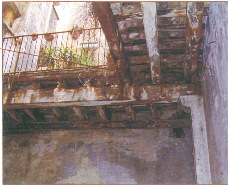
Detall del sistema de suport d'una de les naies o corredors en volada del costat nord oest del pati nord de la finca
