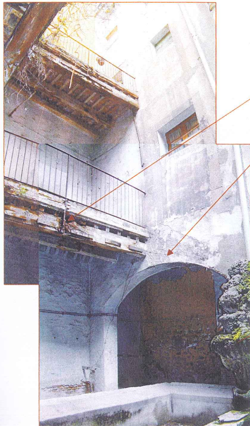
Fotomuntatge de l'angle nord-est del pati central. Podem distingir parcialment la font del safareig d'aquesta part de la finca, així com un dels arcs del pòrtic sobre el que se suporta la façana dels habitatges. També es poder observar els corredors en volada o naies que relacionen a nivell de circulació aquesta zona amb la part nord-oest de la parcel·la
