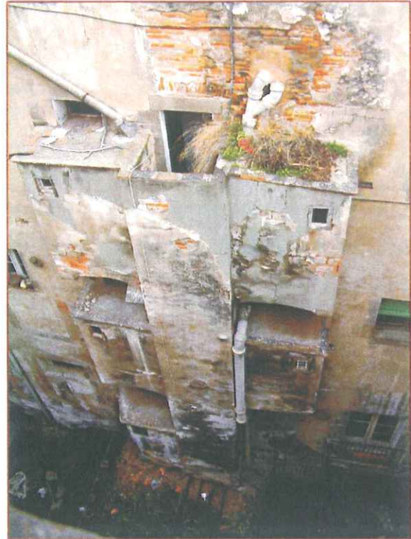
Vista en picat de la zona dels lavabos exteriors de la finca. Podem apreciar que es tracta d'una reforma feta sobre una façana anterior
