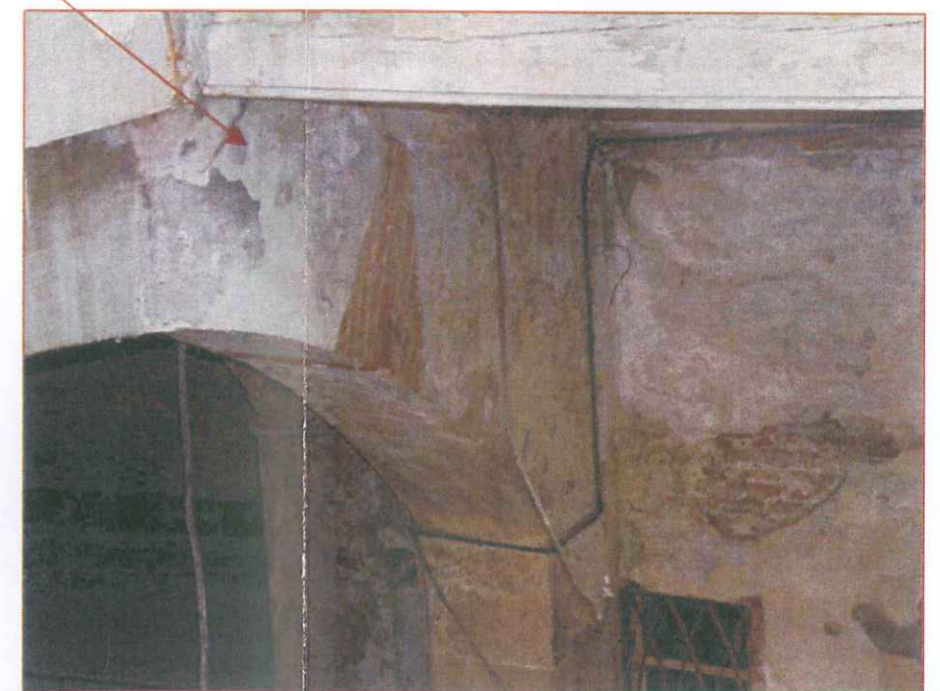
Detall de l'arc més meridional del pòrtic del costat nord-est del pati central. Es pot observar com la disposició al sardinell del maons massissos està configurada tres registres, tot donant a l'arc una amplada i consistència considerable
